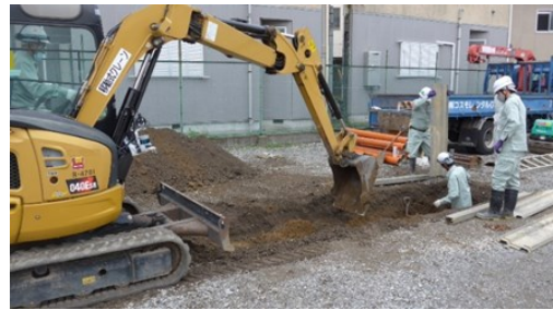
図 2. 模擬施工空間
