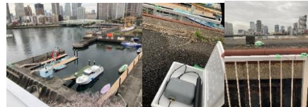
図 3-1: 浮棧橋に設置した GNSS アンテナと RTK 測位端末 ichimill
