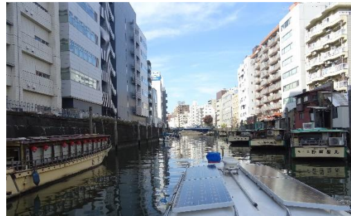
図 2. 神田川護岸・周辺建物の様子
