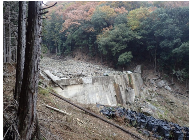
図1 被災した砂防ダムの様子
