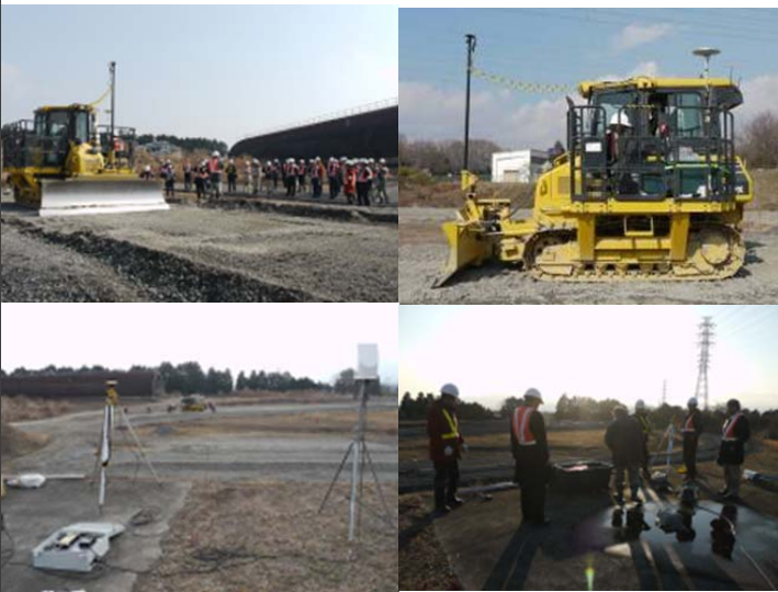
図3 上:ブルドーザでの報化施工(敷均し)実験
